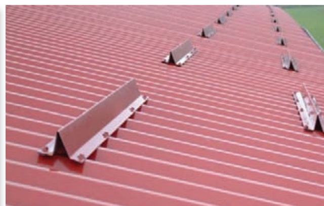
Фото 1.3 Образец С: Снегобарьерные планки
