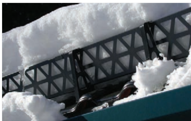
Фото 1.2 Образец В: Снегозадерживающие решетки
