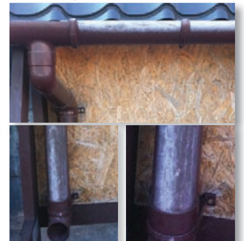
Фото 4 Все полимерные материалы имеют потенциальные проблемы с цветовой стабильностью. С течением времени любой пластик выгорает, истончается и становится более хрупким. За 10 лет работы на рынке, нам приходилось достаточно часто встречаться с подобными случаями
