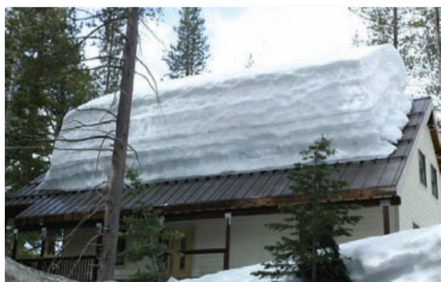
Фото 1. Барьерные снегозадержатели удерживают весь снег на крыше, т.е. кровля практически превращается в сезонный накопитель снега
