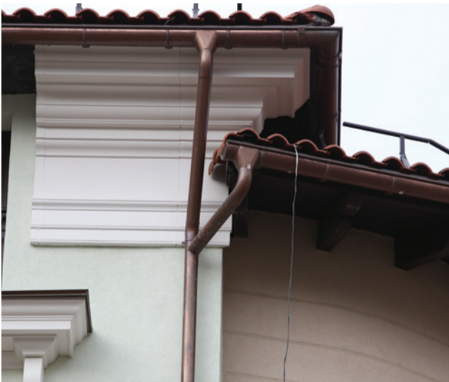
Фото 7 (<< слева) Тройники для труб. Эти элементы необходимы при сборе воды с многоплоскостных кровельных систем
