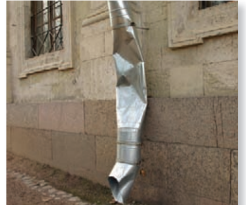
Фото 2 Пример поврежденного водостока
