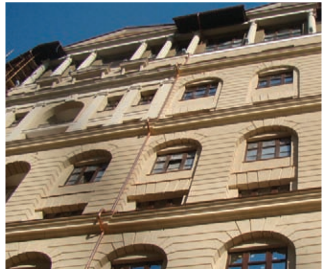
Фото 8 (справа >>) На данной фотографии можно увидеть, какое количество разноуровневых переходов и изломов поверхности заложено в данном архитектурном решении. Именно для того, чтобы компании-подрядчики могли успешно справляться с подобными задачами, и требуется весь набор сложных элементов водосточных систем
