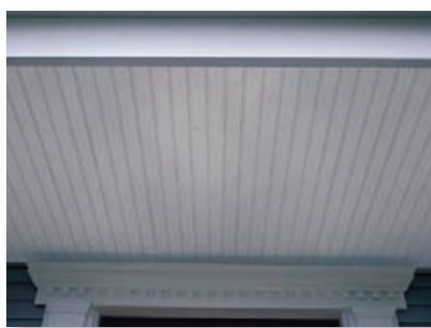
Фото 2 При подшивке карнизного свеса сплошным софитом необходимо обеспечить альтернативные варианты поступления воздуха в подкровельное пространство
