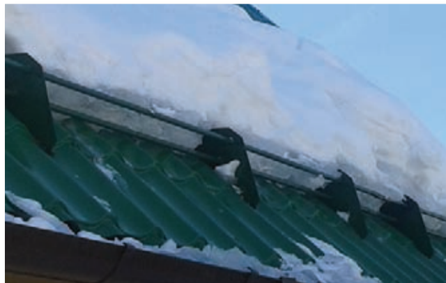
Фото 1.1 Образец А: Трубчатые снегозадержатели
